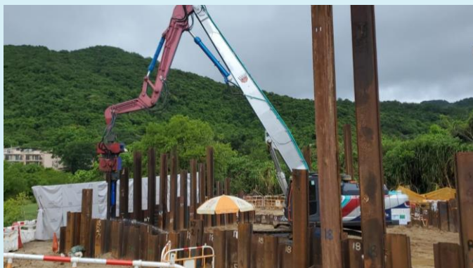
貝澳污水泵房現正進行開挖工作 Excavation for Pui O Sewage Pumping Station
