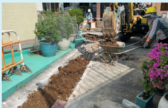
在羅屋村一帶建設污水收集系統 Construction of Village Sewerage at Lo Uk Tsuen
